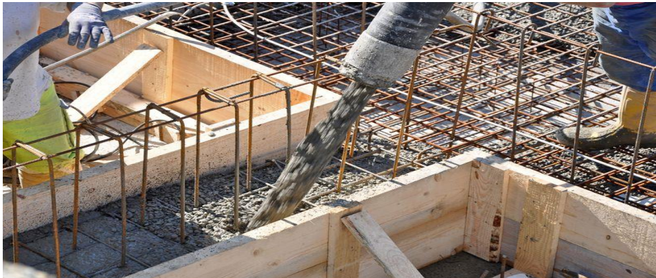
Figure I.2 : Béton fluide pour fondation - © photo 5000, Fotolia
