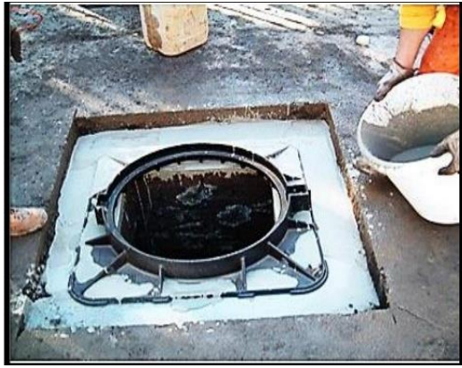
Figure I. 7: Utilisation de MAP pour remplir les conduites et les espaces vides [11]
