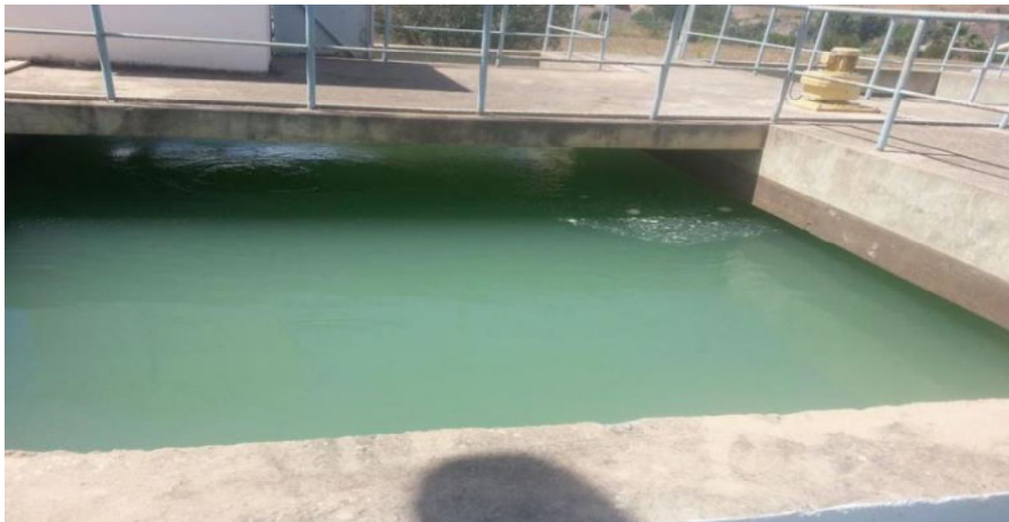
Fig. 1.4. Bassin de floculation.
