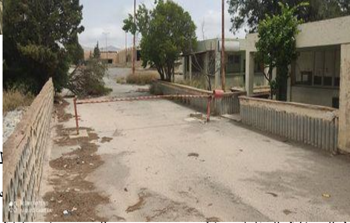
منطقة رمي نفايات مادة تستعمل في بناء البنائات
