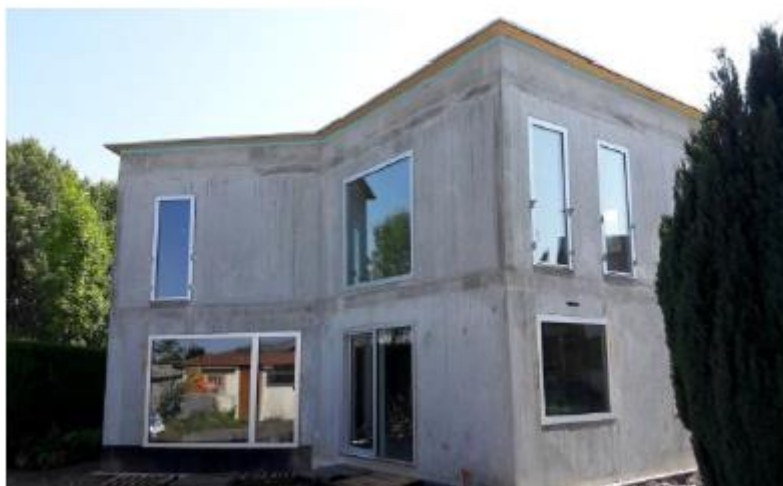
Figure III.1 : Construction d'une maison en voile béton armé.
