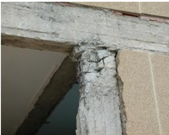
Figure III.4 : Rotule dans le poteau [48]
