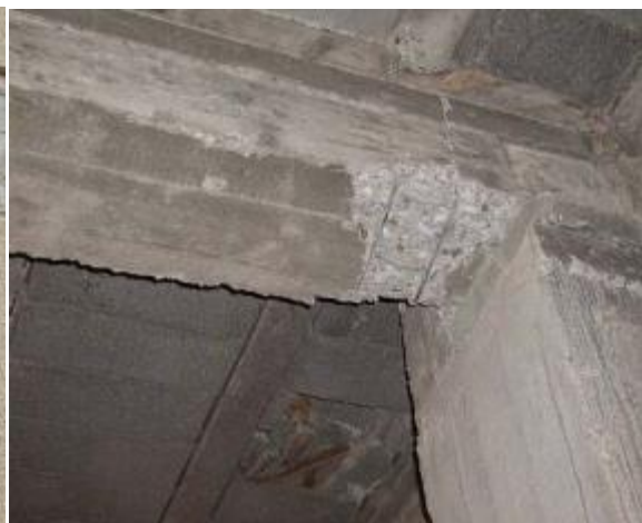
Figure III.5 : Rotule dans la poutre [48]
