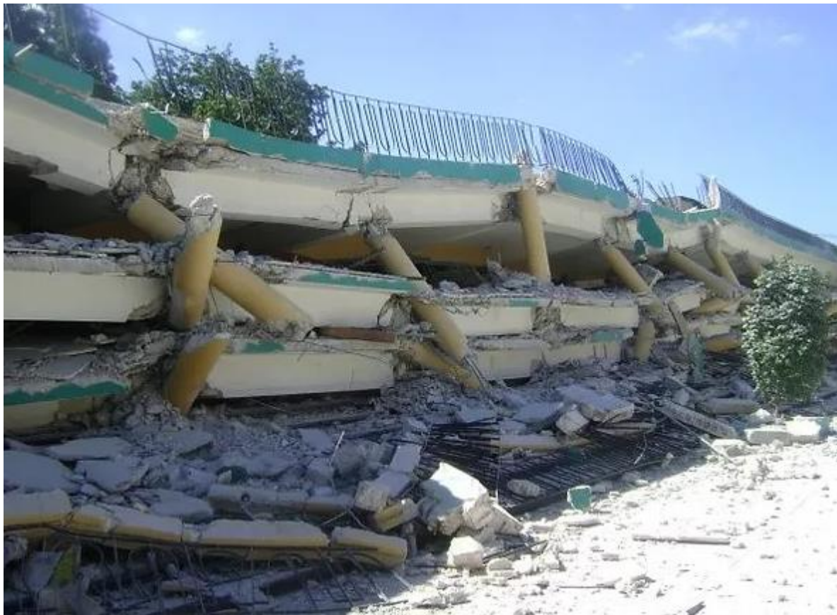
Figure III.16 : Effondrement sous forme d'une galette.
