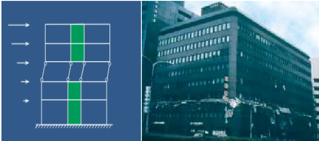
Figure III.20 : troisième étage de cet immeuble[34]
