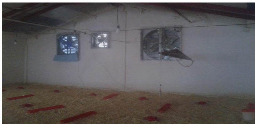
Figure 18 : Bâtiment avec ventilation dynamique
