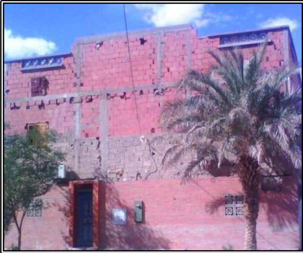
الصورة رقم (12): يوضح مسكن اعتمد في بناءه على مادة الاسمنت والخرسانة المسلحة.
