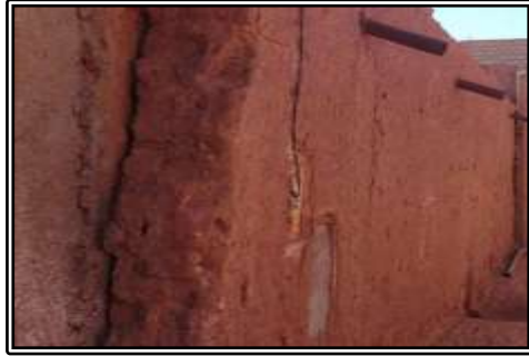
الصورة رقم (10): يوضح جدار الخارجي لمسكن سمكه 50سم.
