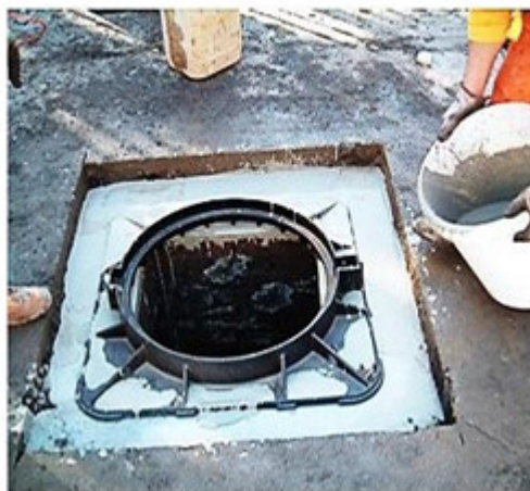
Figure I.4: Utiliser le mortier pour remplir les conduites
