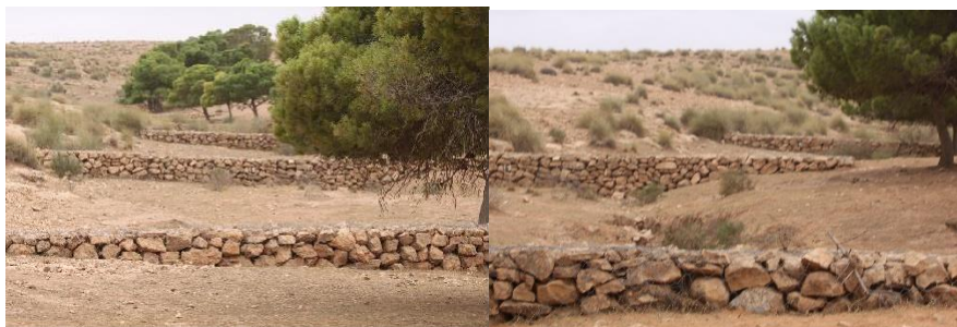
Fig.32.Ouvrages pour consolider les crues torrentielles RNM
