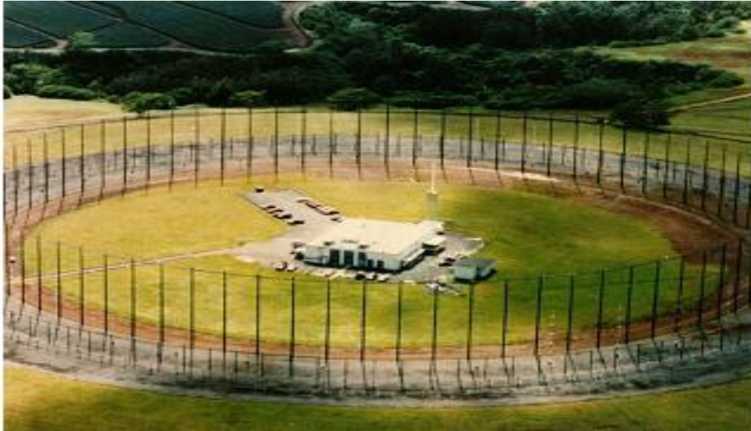
Figure I.8 : Un réseau circulaire installé aux Etats-Unis [23].
