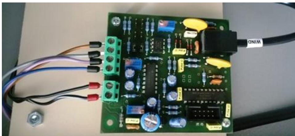
Figure 2.3: Connexion des câbles provenant de l'anémomètre
