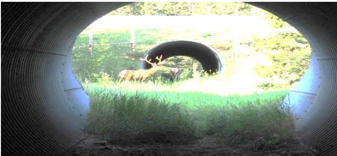
Figure 05 : Un passage souterrain pour la faune. Certaines espèces peuvent être réticentes à emprunter ces passages en raison de l'effet tunnel (Tony,2012)
