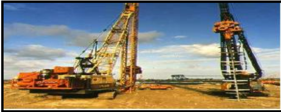
Figure II.3 : Compactage par vibro-sonde. [3]
