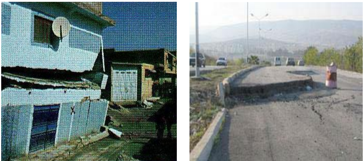
Figure I. 3 : effondrement de ville de Cheria en 2009 et les dommages induits. [8]
