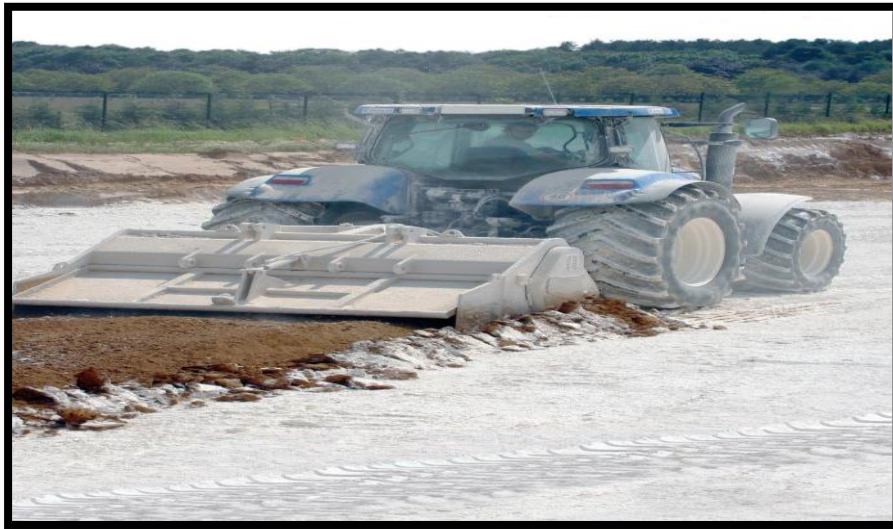
Figure II.6 : Traitement par la chaux. [3]
