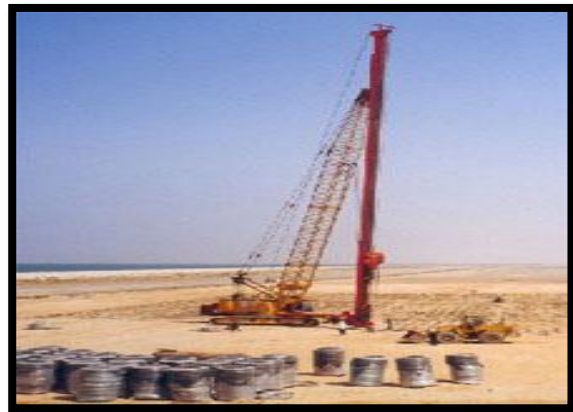
Figure II.14: Principe de traitement avec les DV En plastique. [6] Figure II.15 : Traitement par DV [6]
