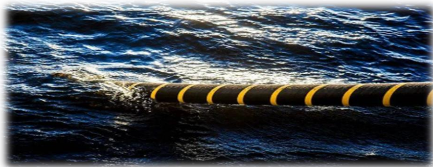
Figure 1.6: Câbles de transmission d'énergie sous-marine
