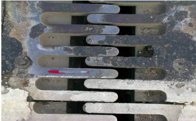
Figure II.18: Partie d'un joint de dilatation entre deux portions d'une route (sa longueur totale qui est la largeur de la route est 10,5 m) [11].
