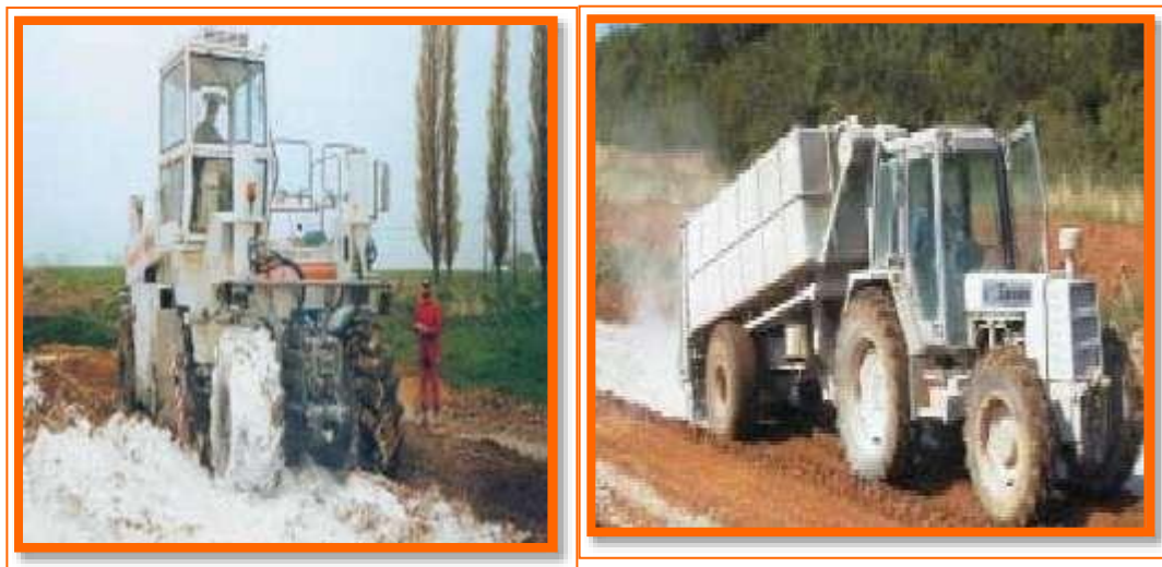
Figure. I.13: Traitement chimique à la chaux et au ciment.
