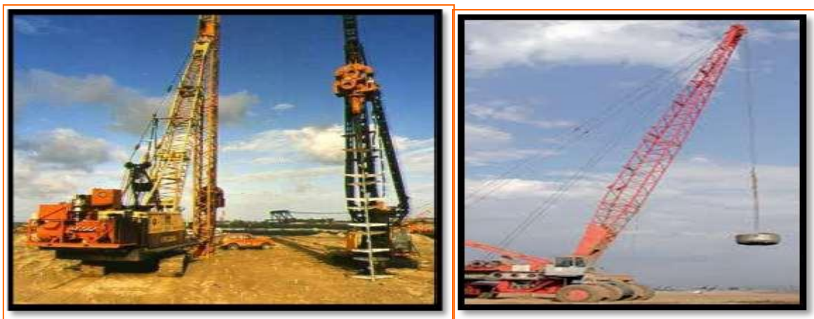
Figure. I.11 : Compactage par vibro-sonde.
