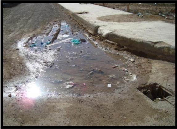
صورة رقم (24): عدم أخذ الميل بعين الاعتبار في عملية ترفيت الطرق
