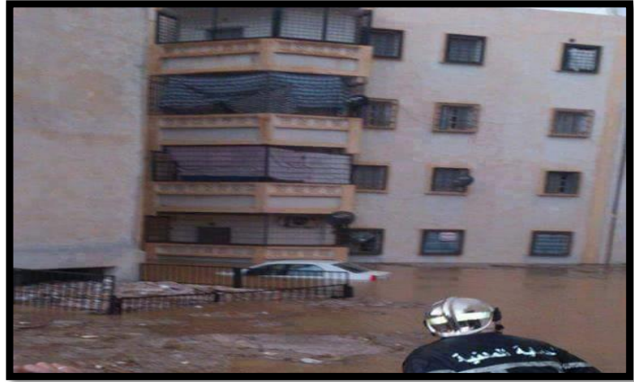
صوررقم (39) : توضح غمر مياه الفيضانات 2015 لمنطقة الدراسة على مستوى الطابق الأرضي
