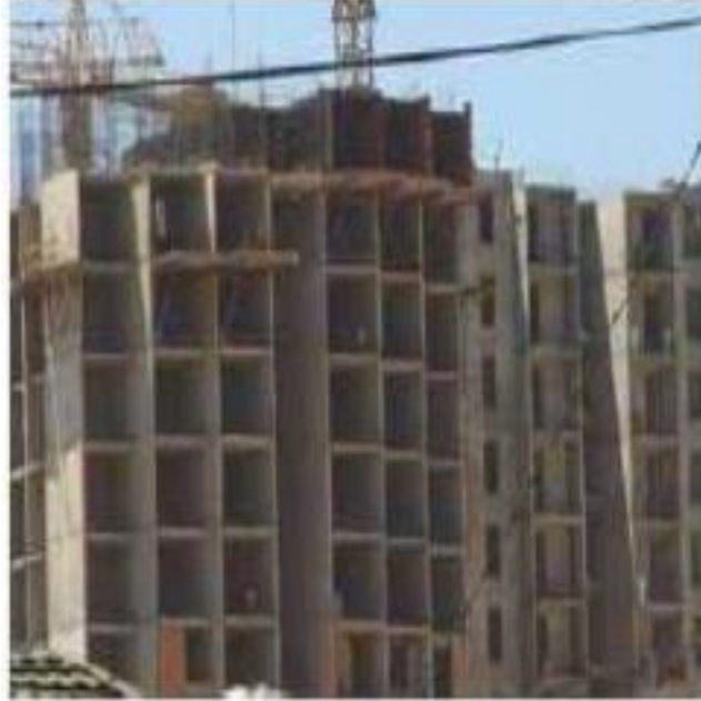
Figure II.2 : Ossature contreventée par voiles en béton armé [1]
