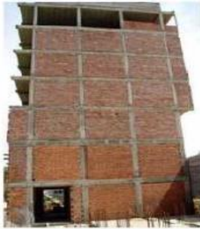
Figure II.1 : Ossature contreventée par portique auto stable.
