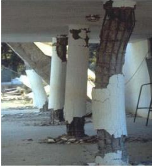
Figure II.9 : flambement des poteaux [1]
