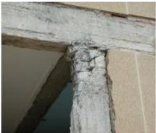
Figure II.5 Rotule dans le poteau (comportement à éviter) [7]
