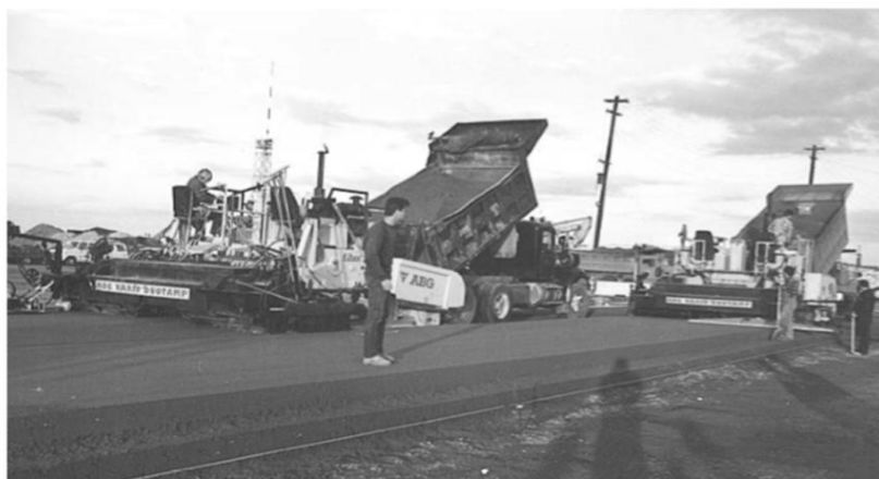
Fig. 1.2. Mise en place d'un BCR routier[10].
