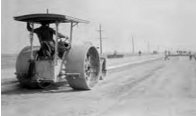
Fig. 1.4. Une technique de pavage considérée comme BCR en Suède en 1930 [13].
