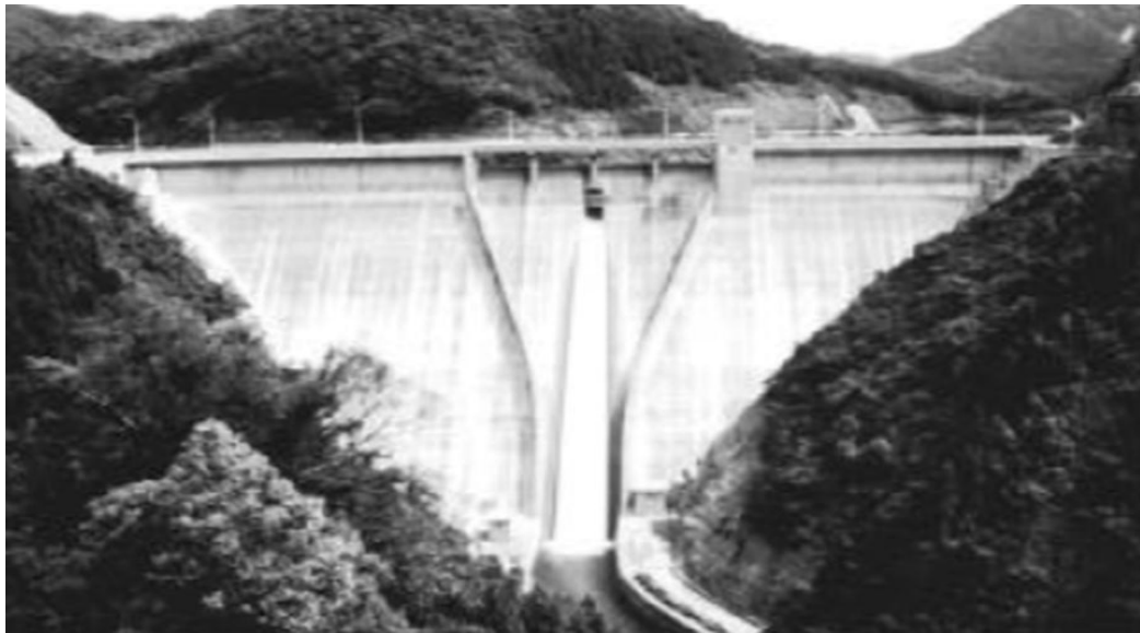
Fig. 1.6. Barrage de Shimajigawa au Japon [15].
