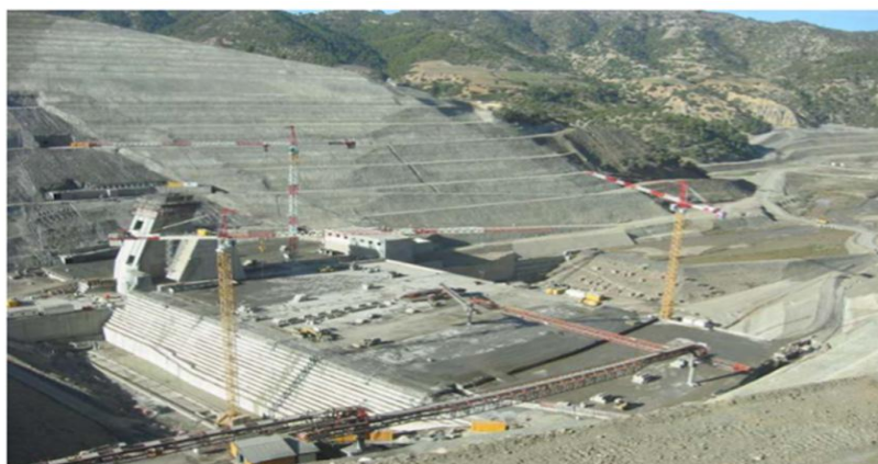
Fig. 1.3. Barrage de Koudiat-Acerdoune en Algérie, pendant la construction
