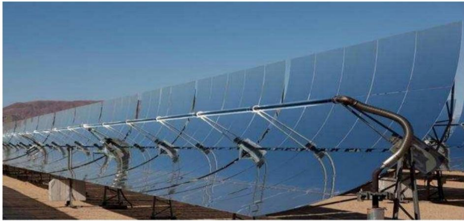
الشكل I-12: المجمع الحراري المكافئ المركز
