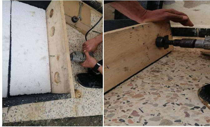
Fig. 3.5 formation des trous dans la partie inférieure et supérieure de boîte rectangulaire
