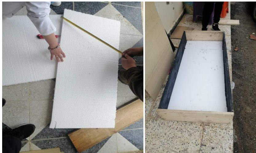
Fig. 3.6 Fixation de polystyrène et l'aluminium
