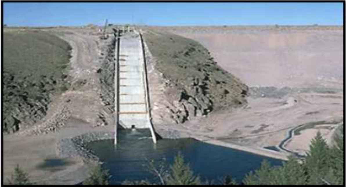
Figure I- 8-Photo de vue du barrage de Teton (rive nord proche de l'évacuateur).
