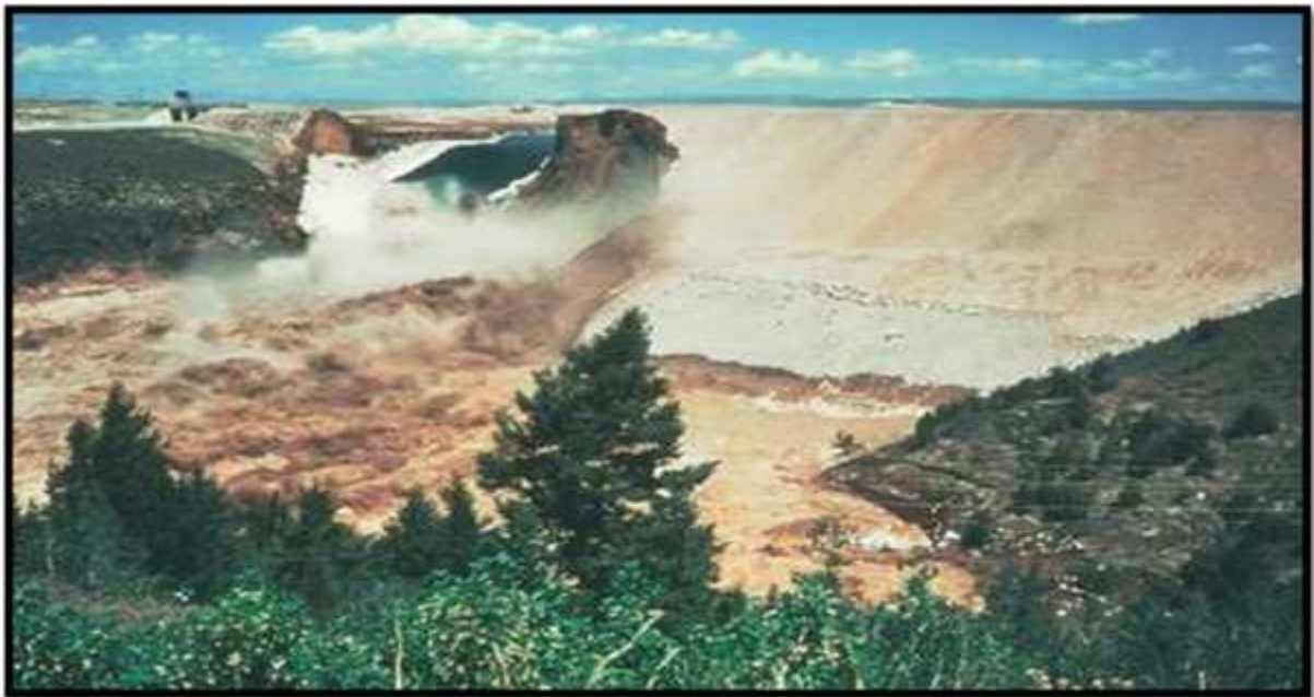
Figure I- 9-Rupture du barrage de Teton.
