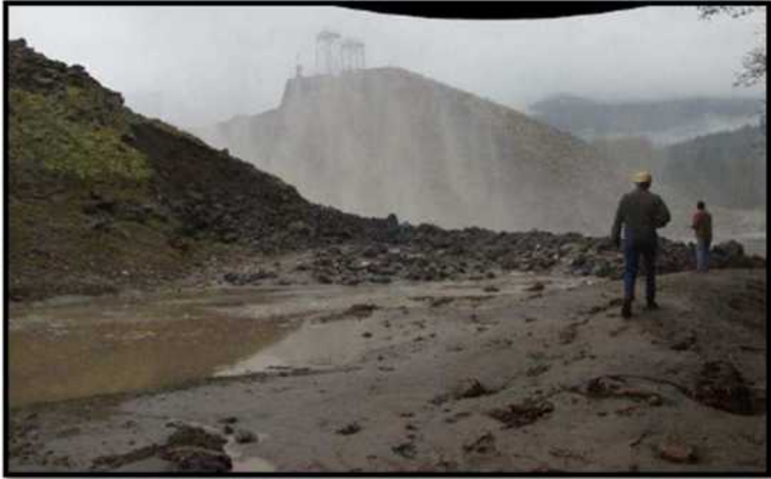
Figure I- 7- Etat final de la rupture du barrage de Swift.
