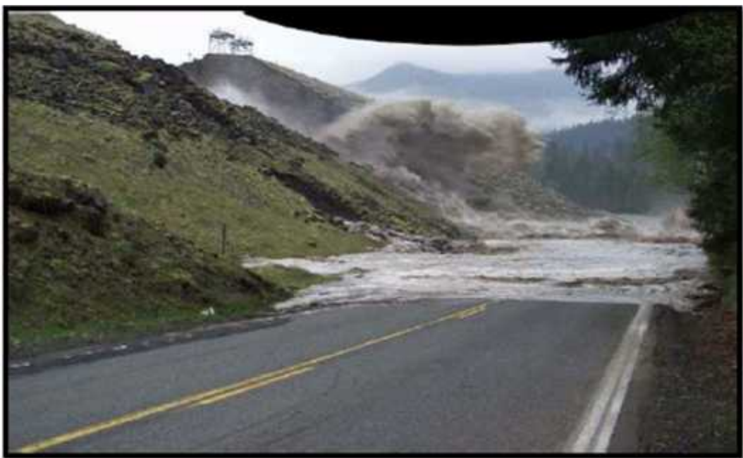
Figure I- 6- Les premières heures de rupture du barrage de Swift.
