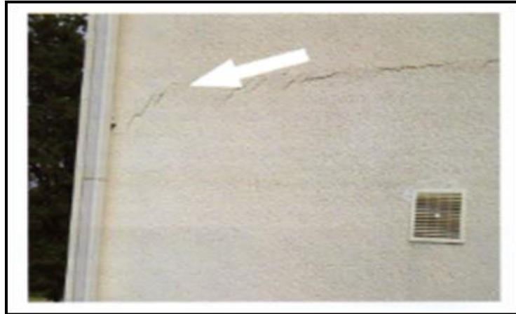
Figure I.16 : Le plancher des combles de cet immeuble s'est dilaté.
