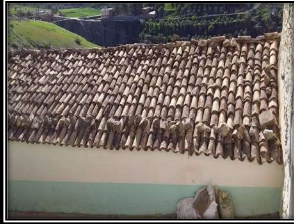
الصورة 29: نموذج لسطح مسجد أولاد داود
