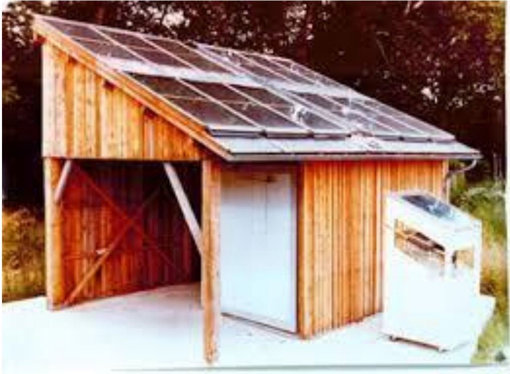
Fig. LI : photo de l'entrepôt frigorifique solaire à adsorption.
