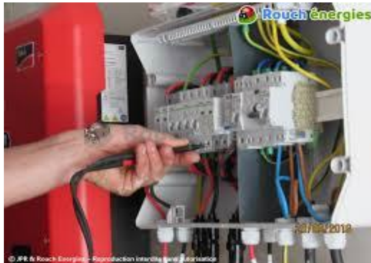
Fig 22. Exemple de boîte de jonction et câblage
