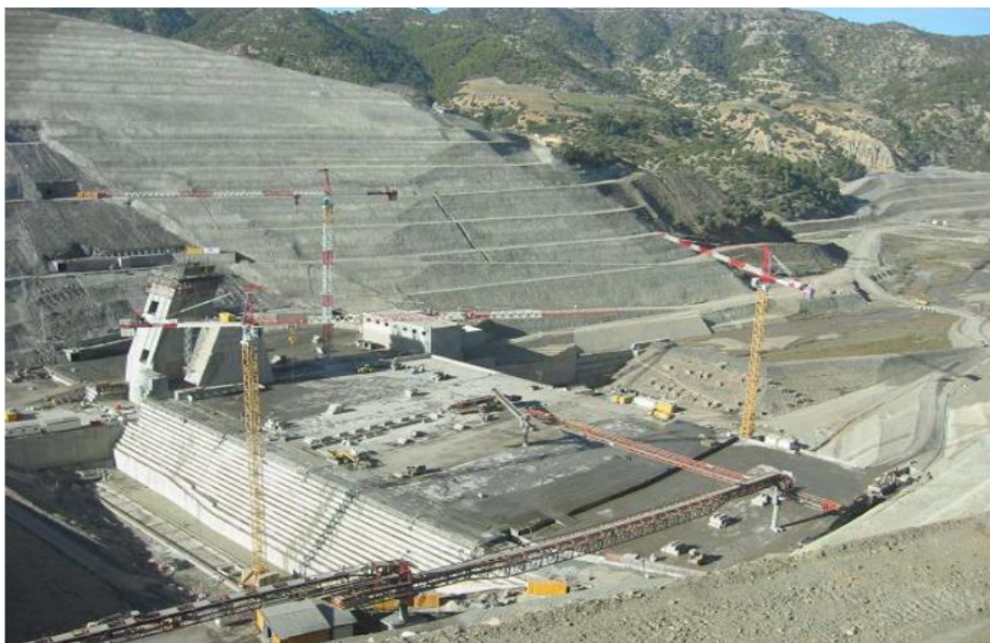
Figure I.2 : Barrage de Koudiat-Acerdoune en Algérie, pendant la construction (Bouyge & Forbes, 2007).
