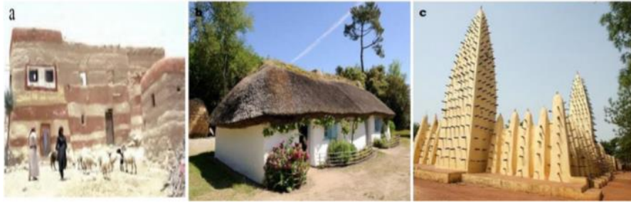
Figure I. 7: construction en terre empilée: (a) maison à sadah Yémen, (b) Bourrine de Vendée; (c) mosquée deBobo Dioulasso.
