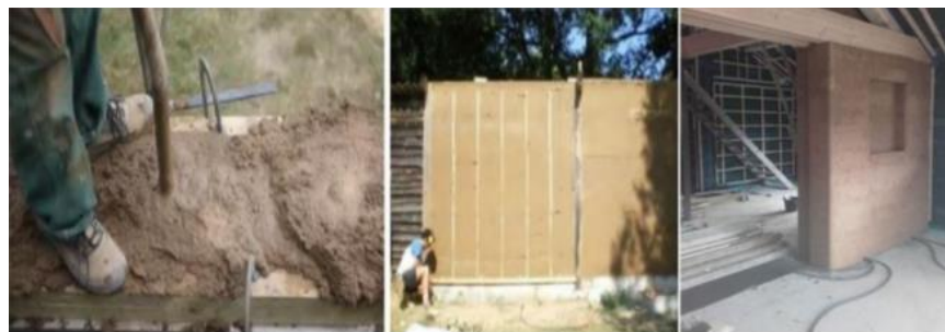
Figure I. 6: exemple de mur en terre coulée.
