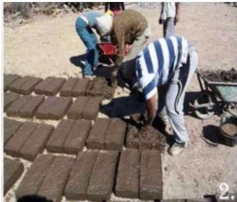
Figure I. 2 : Exemple de Fabrication d'Adobe (Kaddour B A & Benchemma, 2017)
