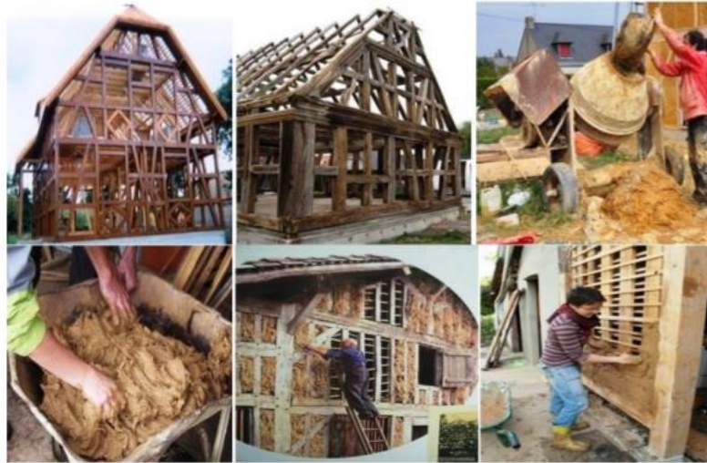
Figure I. 5: techniques de construction en torchis alsace France.
