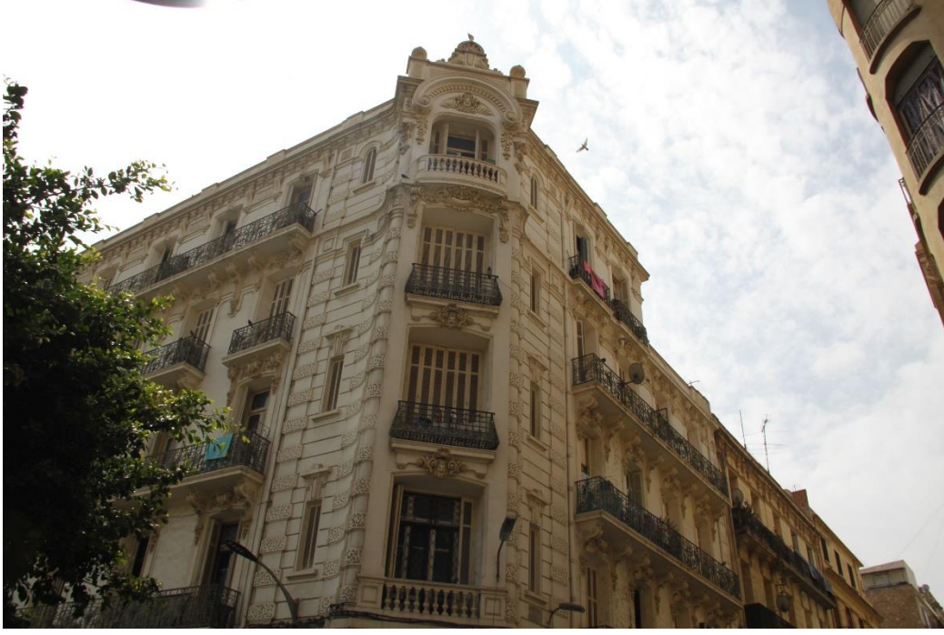
الصورة (109) توضح واجهة البنايات بعد عملية الترميم 2024
