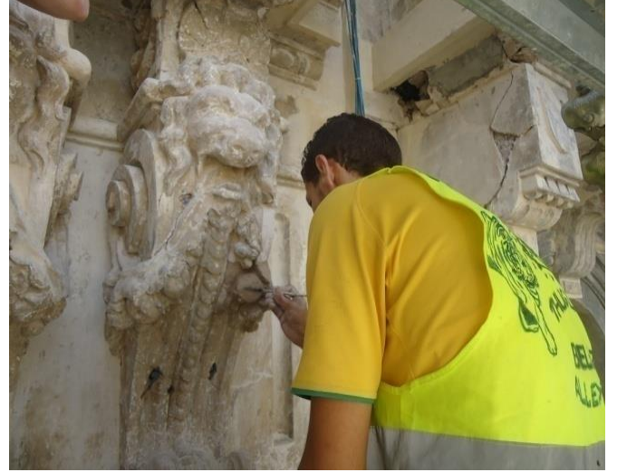
الصورة (83)(84) توضح ترميم الزخارف واستعادة الديكورات المصدر: تقرير إعادة تأهيل المباني، الورشة التكوينية 2018
