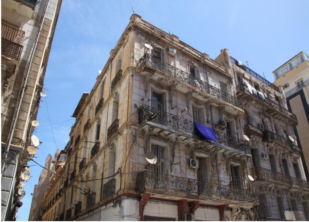
الصورة (44) توضح حالة البنايات 2022
