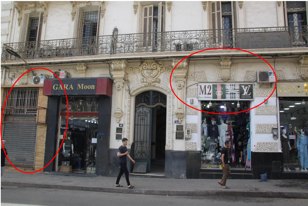
الصورة (94) توضح واجهة بناية بعد عملية الترميم
