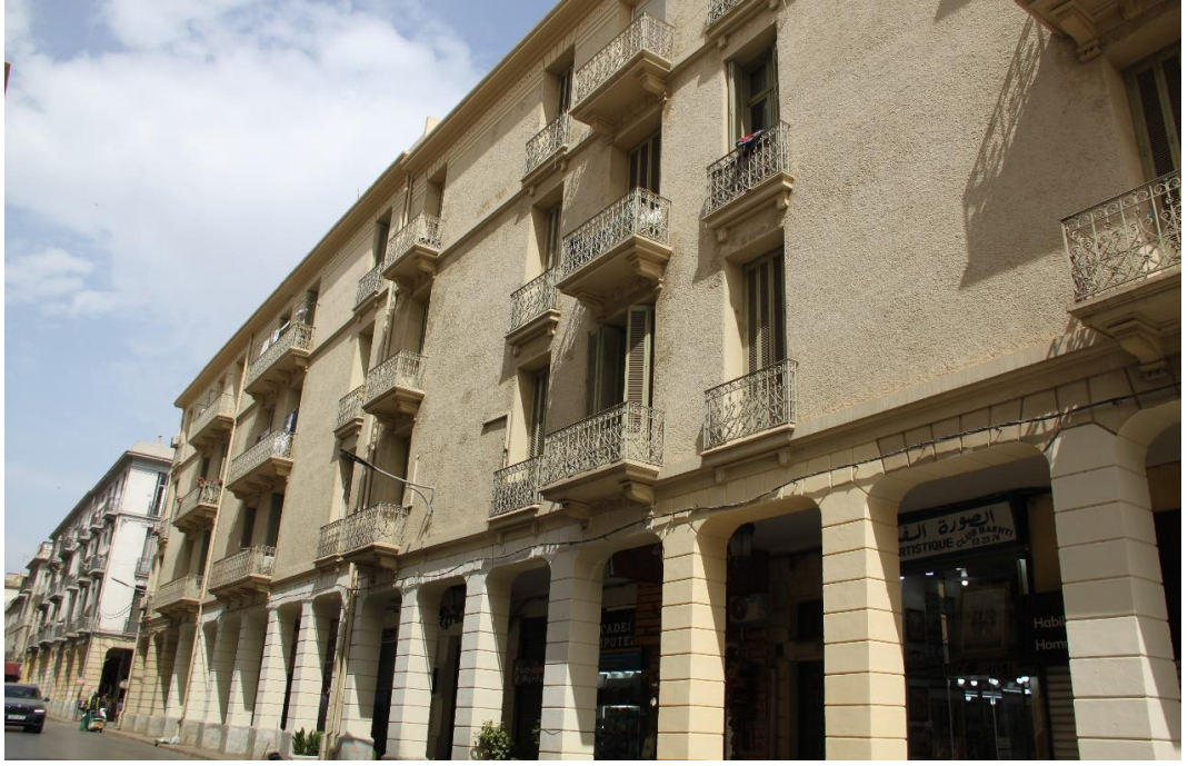
الصورة(95) توضح واجهة بناية بعد عملية التدخل الشارع الرئيسي العربي بن مهدي
