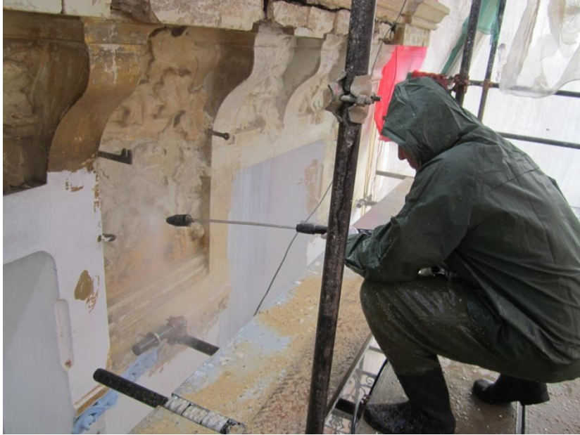
الصورة (69) توضح طريقة تنظيف الاسطح
