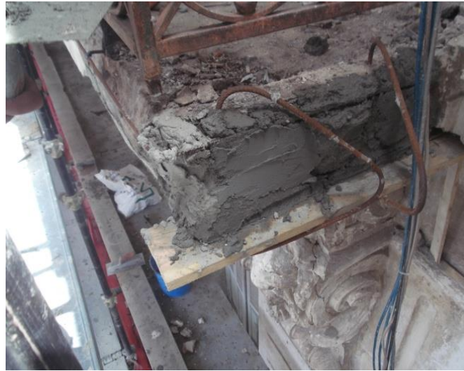
الصورة (90) تمثل تدعيم أرضية الشرفات المصدر: تقرير إعادة تأهيل المباني، الورشة التكوينية 2018
