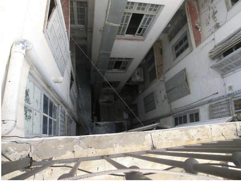
الصورة (107) توضح الفناء الداخلي للبناءية قبل التدخل المصدر: مكتب الدراسات
