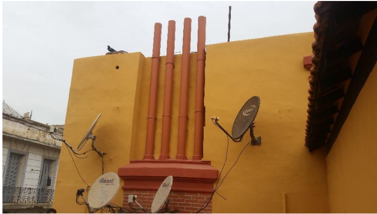
الصورة (100) توضح واجهة الخلفية لنفس البناية بعد عملية التدخل
