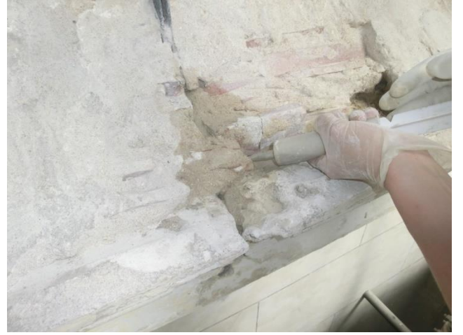
الصورة (88) (89) تمثل نموذج لترميم التشققات الداخلية وتدعيمها المصدر: تقرير إعادة تأهيل المباني، الورشة التكوينية 2018
