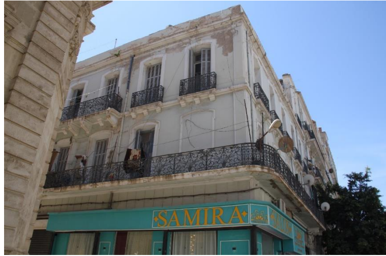
الصورة(55) توضح بناية بشارع معطى محمد الحبيب بعد ترميمها في مشروع 200 بناية
