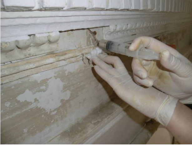
الصورة (88) (89) تمثل نموذج لترميم التشققات الداخلية وتدعيمها المصدر: تقرير إعادة تأهيل المباني، الورشة التكوينية 2018
