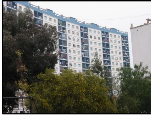
الصور (31) توضح أمثلة عن البنائيات التي تم تحسينها Cité Jean Lafontaine
