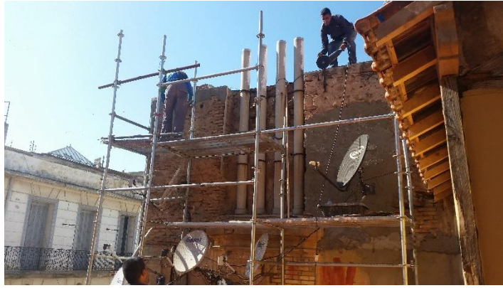
الصورة (99) توضح واجهة الخلفية لنفس البناية قبل عملية التدخل
