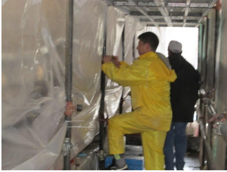
الصورة (68) توضح مرحلة التحضير لعملية تنظيف الواجهات
