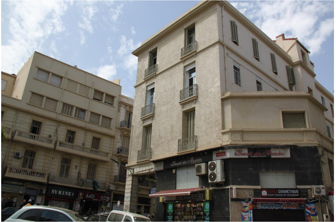
الصورة(96) توضح البنايات التي تم ترميمها الشارع الرئيسي العربي بن مهدي
