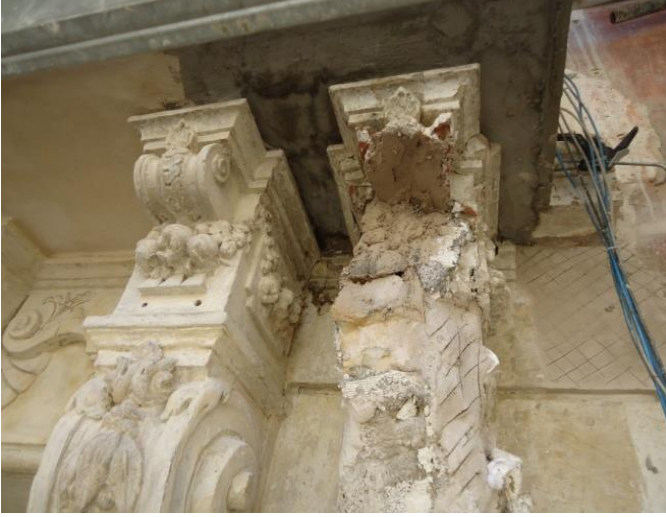
الصورة (83)(84) توضح ترميم الزخارف واستعادة الديكورات المصدر: تقرير إعادة تأهيل المباني، الورشة التكوينية 2018
