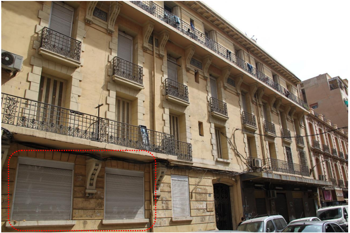
الصورة (104) توضح التغيرات على واجهة البناية بعد عملية الترميم
