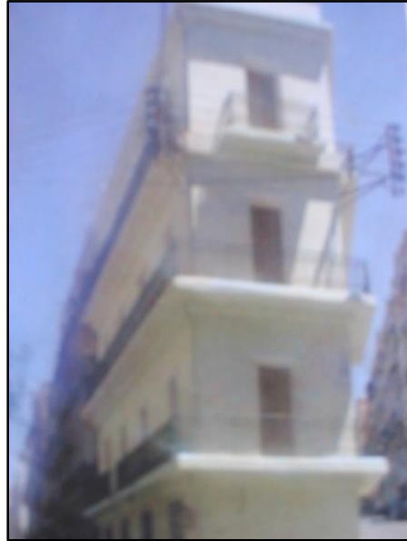
الصورة (29) (30) توضح البناية بحي (Maréchal des Logis , St Pierre) قبل التدخل وبعد التدخل المصدر: ديوان الترقية والتسيير العقاري بمدينة وهران
