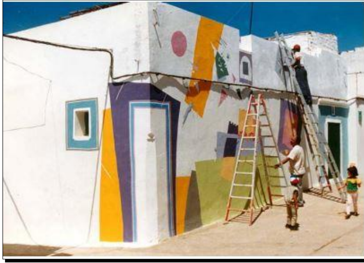
الصورة (8): الرسوم الجدارية على المباني التي تم إعادة تأهيلها المصدر: Agha Khan Foundation
