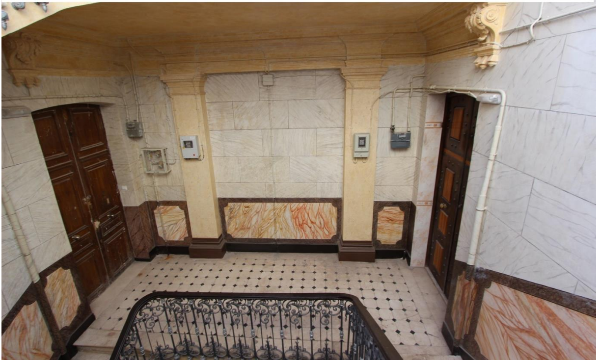
الصورة (113) توضح ترميم بناية من الداخل بشارع الصومام
