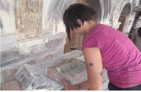
الصورة (73) صب المكون داخل الطبقات باستخدام مادة الجسمونيت (jesmontine) ومسحوق الرخام
