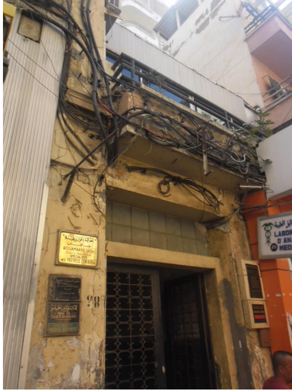
الصورة (65) توضح حالة مدخل البناية
