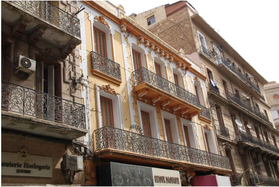
الصورة (110) توضح واجهة البنايات بعد عملية الترميم 2024
