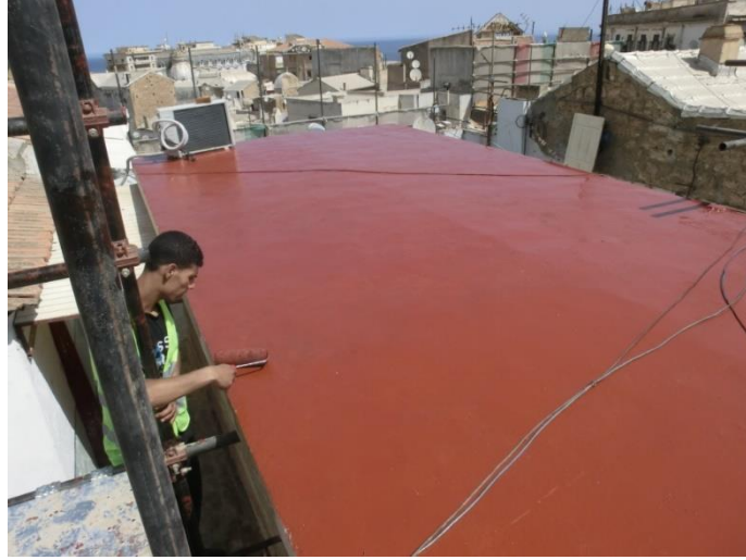
الصورة (91) توضح طريقة العزل المائي
