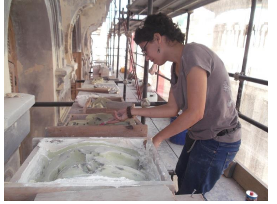
الصورة (72) توضح إنشاء القوالب الخشبية
