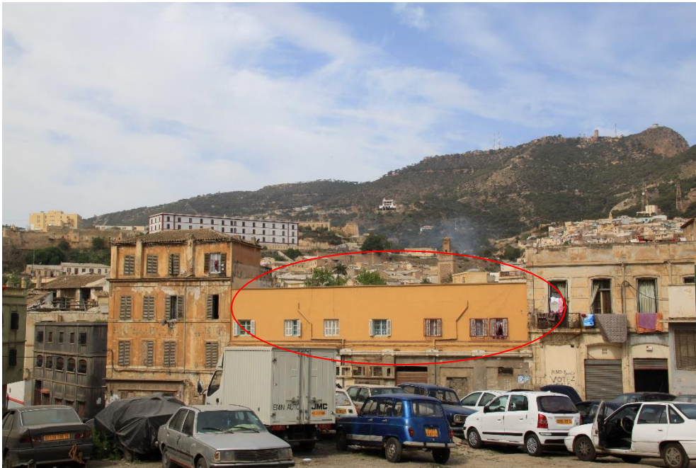
الصورة (39) تجاوزات البناء والتغيير الواضح في الحي التاريخي
