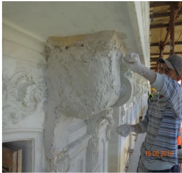
الصورة(64) توضح تقنية ترميم الواجهات
