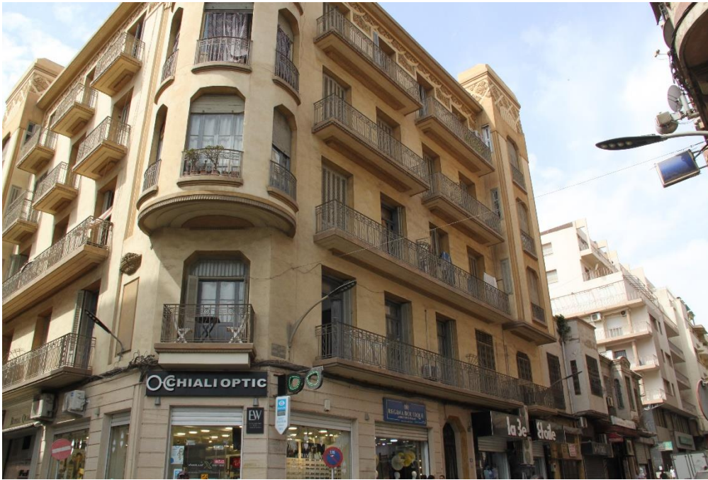
الصورة (103) توضح واجهة البنايات بعد عملية الترميم
