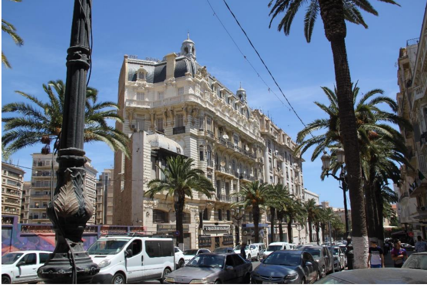
الصورة (112) توضح منظر شارع الصومام
