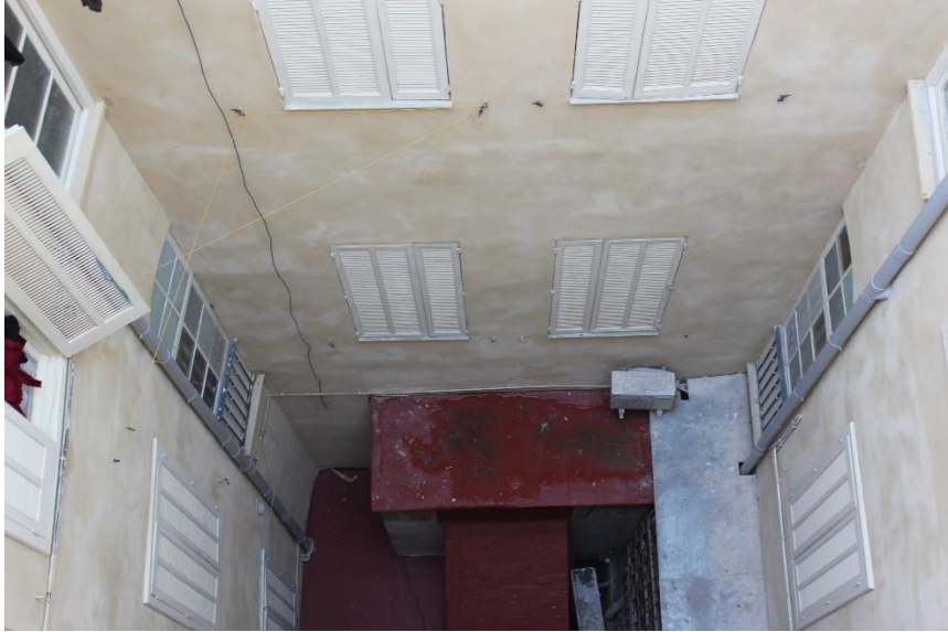
الصورة (108) توضح الفناء الداخلي للبناءية بعد عملية ترميم 2018
