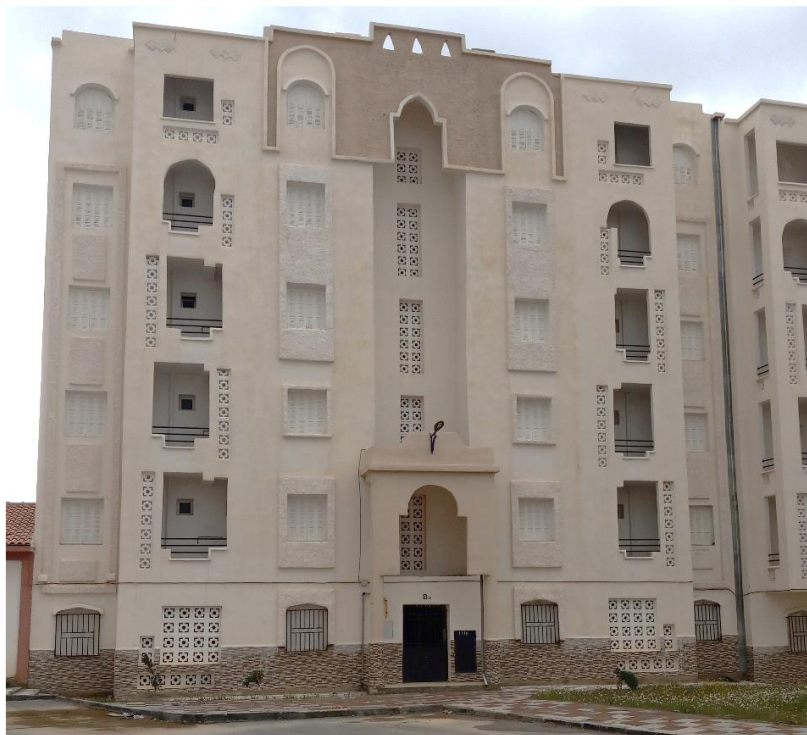
Figure V.3. Vue de face du bâtiment.
