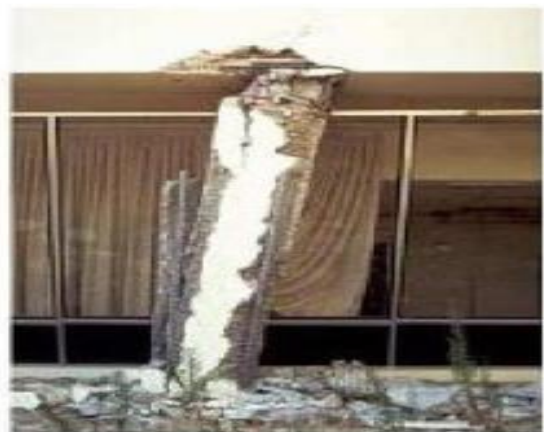
Figure III.9 : disposition incorrecte des cadres [55]
