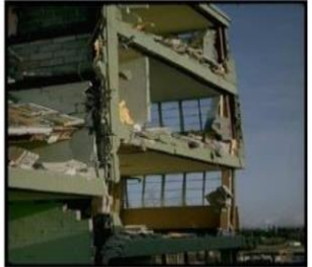
Figure III.11 : maçonnerie non chaînée [55]
