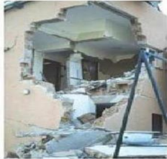
Figure III.12 : maçonnerie non chaînée [55]
