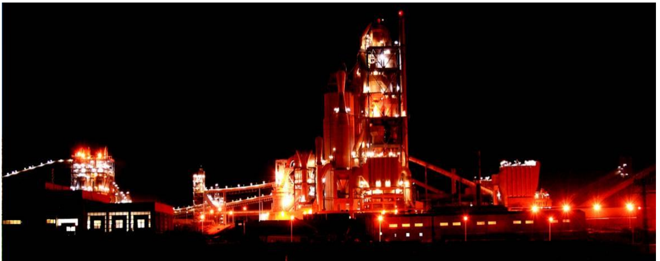
Figure.9. Vu globale de nuit del'usine Lafarge ciment de m'sila LCM
