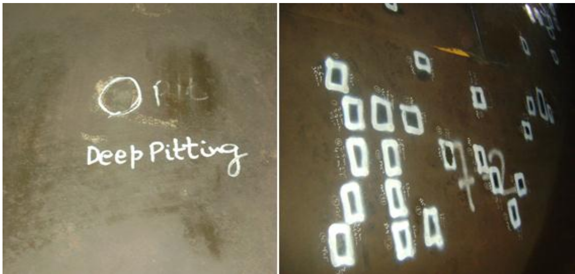
Figure(4.2): Le contrôle visuel.
