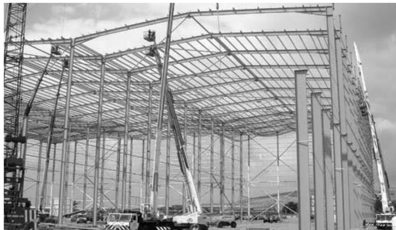
Fig. 1.5: Processus d'installation d'un portique moderne
