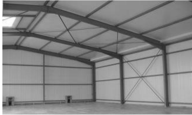
Fig. 1.10: Détails du contreventement
