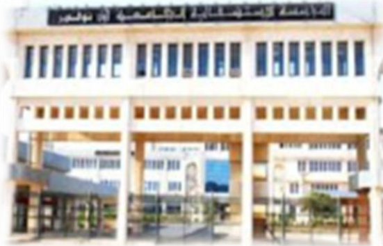
Figure n °25 : Hôpital de 01 Novembre
