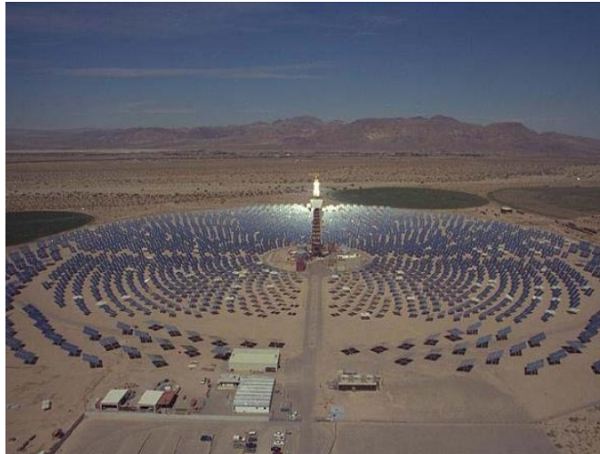
Fig. 2.7 Système de centrale à tour
