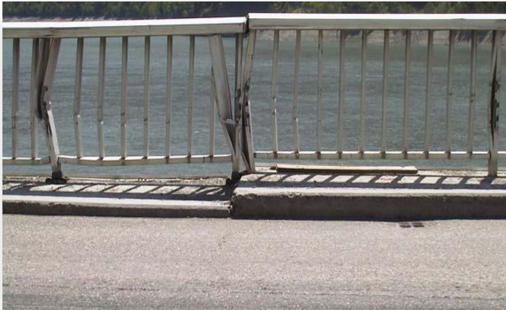
8.b) Exhaussement des bordures de crête sur le barrage du Chambon.
