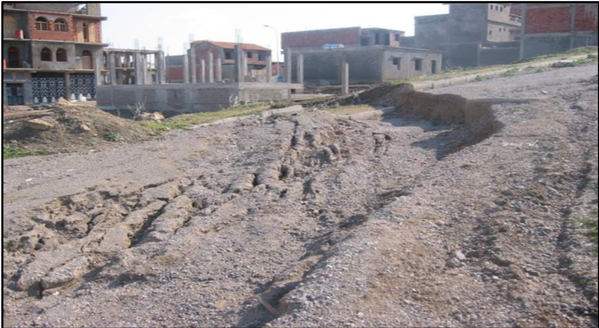
Photo 13 Glissement superficiel qui a affecté la route d'accès coté Est de la cité
