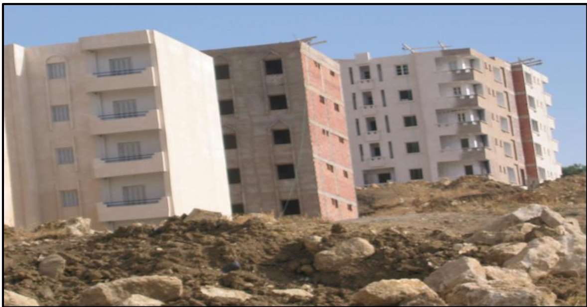
Photo 12 Projet 185 logements en cours de réalisation sur une assise argileuse profonde
