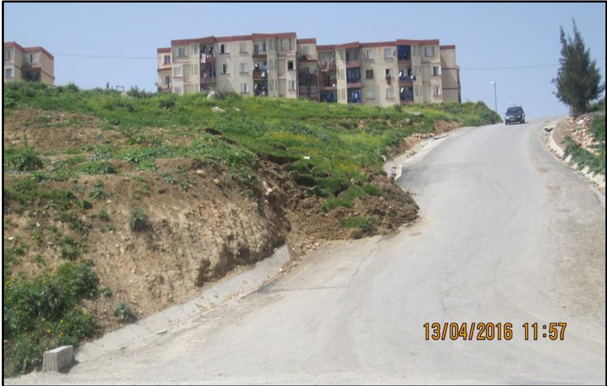
Photo 24 Un nouveau glissement de terrain qui menace quelques blocs ;cité Mila lagdima
