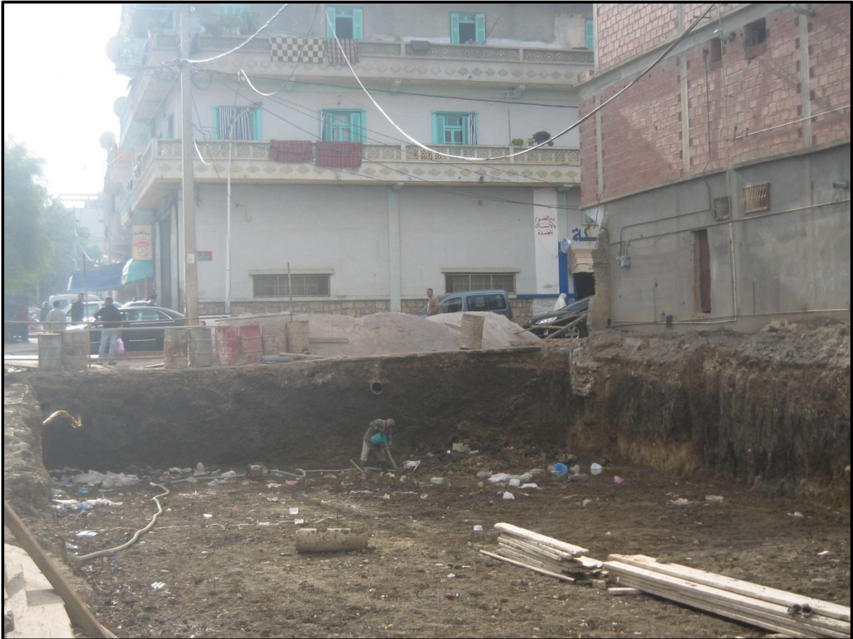
Photo 15 Travaux de terrassement pour la réalisation de la CASNOS centre-ville Mila ; le niveau piézométrique est 1.5 m, les volumes d'eaux arrivées en surface sont dégagées avec un moteur hors site.
