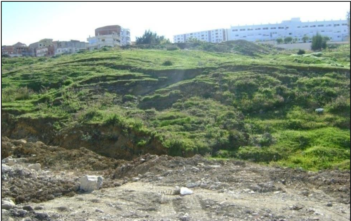
Photo 23 Un glissement de terrain qui menace l'hôpital de Mila et quelques habitations
