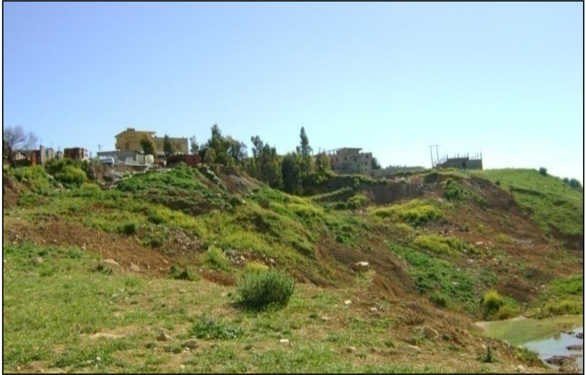
Photo 22 Le glissement de terrain au lotissement nord de Mila. Cité Tyayba
