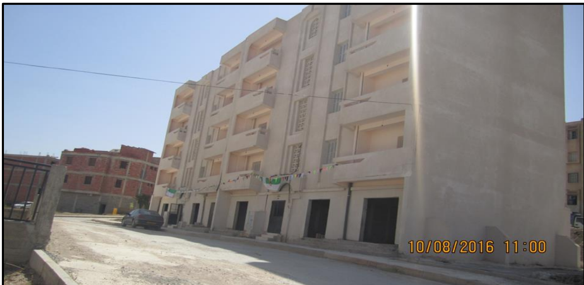
Photo 21 Les 32 logements réhabilités pour être distribué en Juillet 2016
