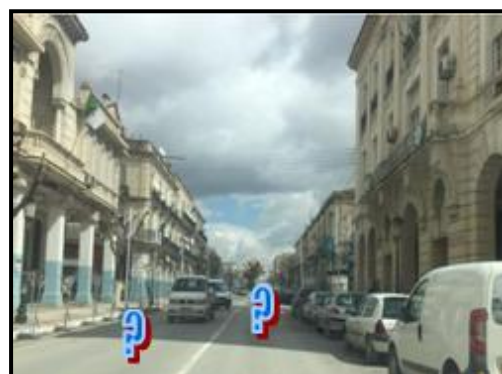
photo 50 : absence d'ilot de refuge et Aménagement de P.M.R
