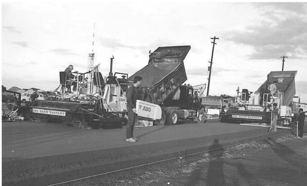
Figure I.4 : Mise en place d'un BCR routier (ACI Committee, 2001).
