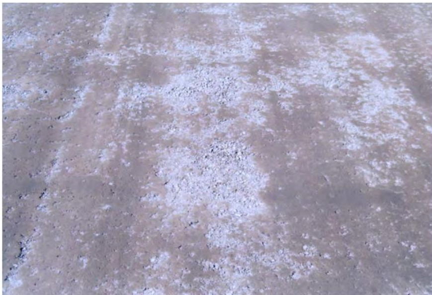
Figure I.8 : Texture ouverte : ségrégation (Tiré du rapport du Service d'expertise en matériaux (S.E.M)).
