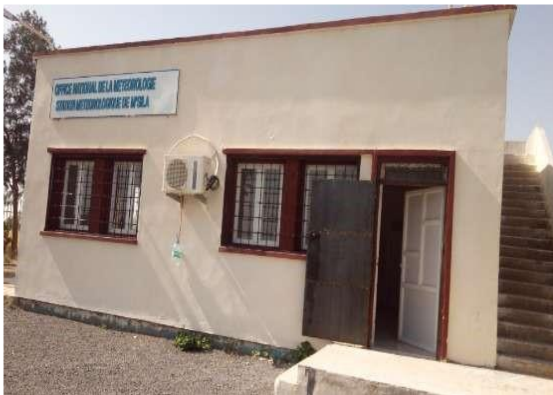
Figure( III .2): Station météorologique de M'sila.
