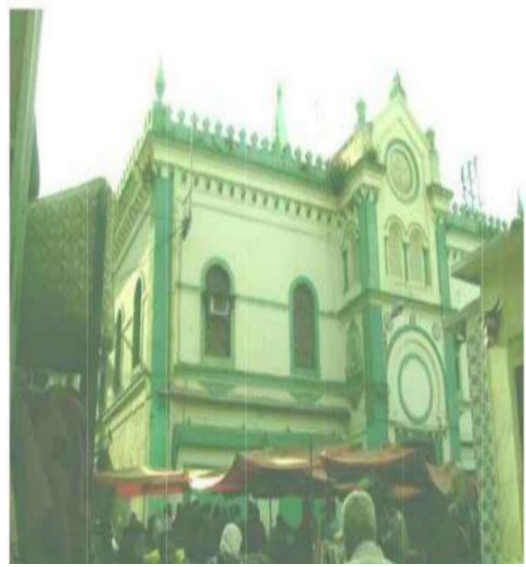
الواجهة الشرقية بجامع سيدي الكتاني
