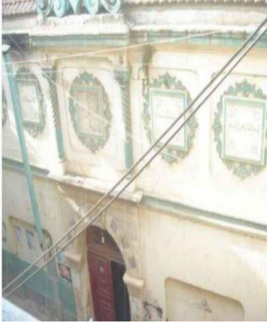
الواجهة الجنوبية بجامع سيدي الكتاني
