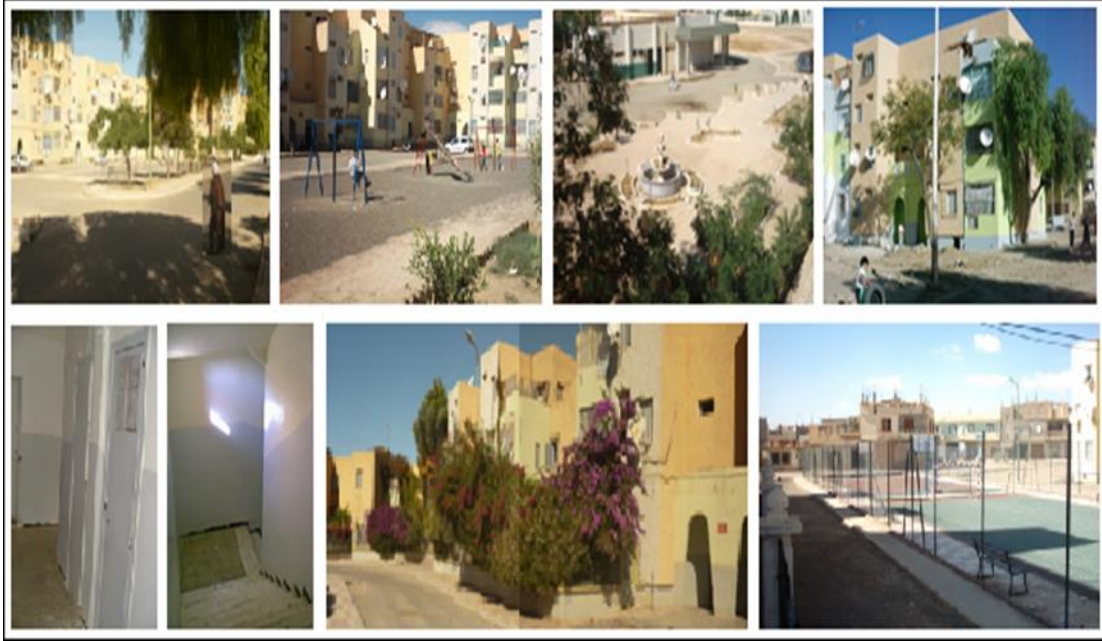
الشكل رقم 40: حي 300 مسكن النهضة قبل وبعد عملية إعادة التأهيل
