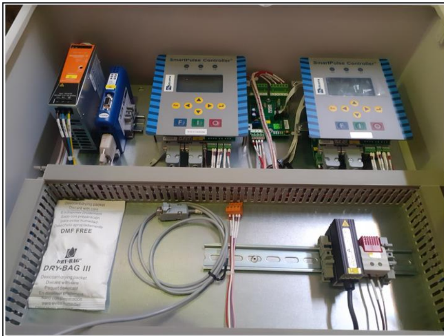
Figure 22. Contrôleur maître SPC
