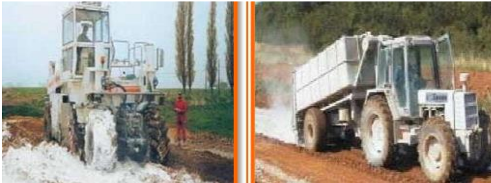
Figure I.15 : Traitement chimique à la chaux et au ciment.
