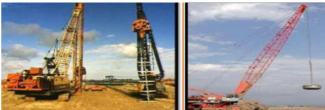
Figure I.13 : Compactage par vibro-sonde.
