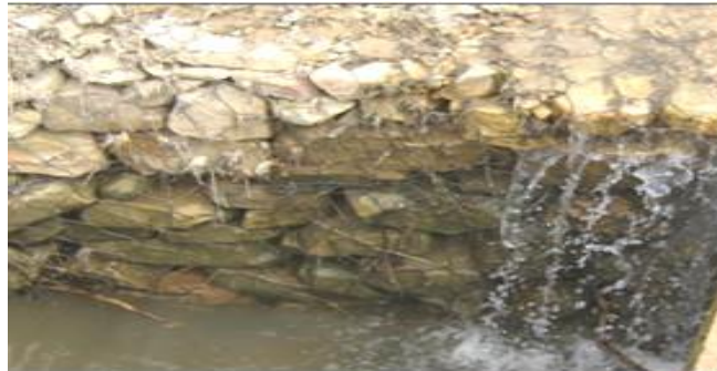
Figure I.6 : Seuils de sédimentation en Gabion et en pierres sèches réalisées dans le bassin versant du barrage BAKHADDA[2].
