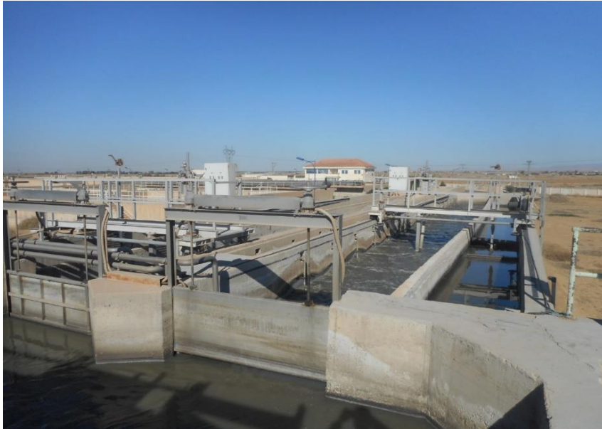
Figure II-10: Dessableur-dégraisseur rectangulaire
