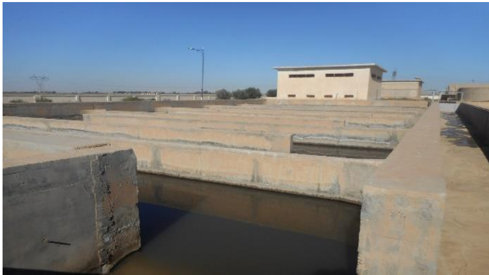
Figure II-14 : Bassin de chloration
