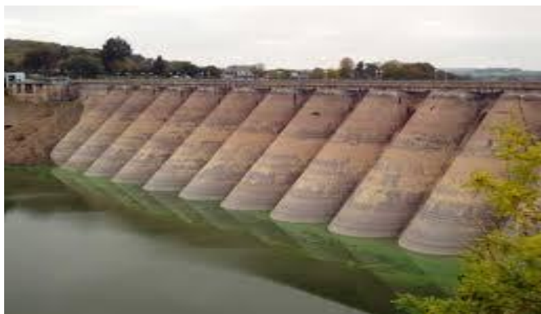
Figure I-8- Barrage à Multi-voûtes
