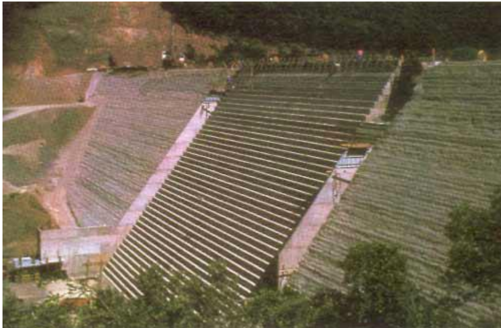
Figure I-10- Barrage en béton compacté au rouleau.
