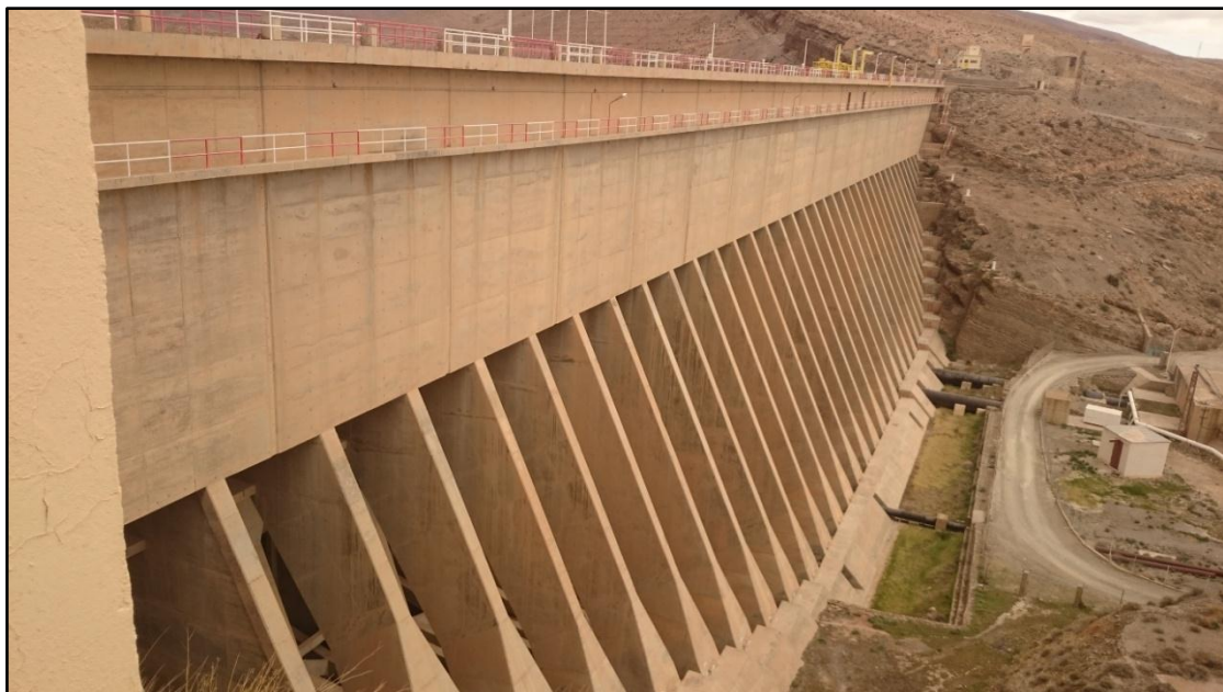
Figure III-5- Photo des contreforts du barrage EL K'sob.
