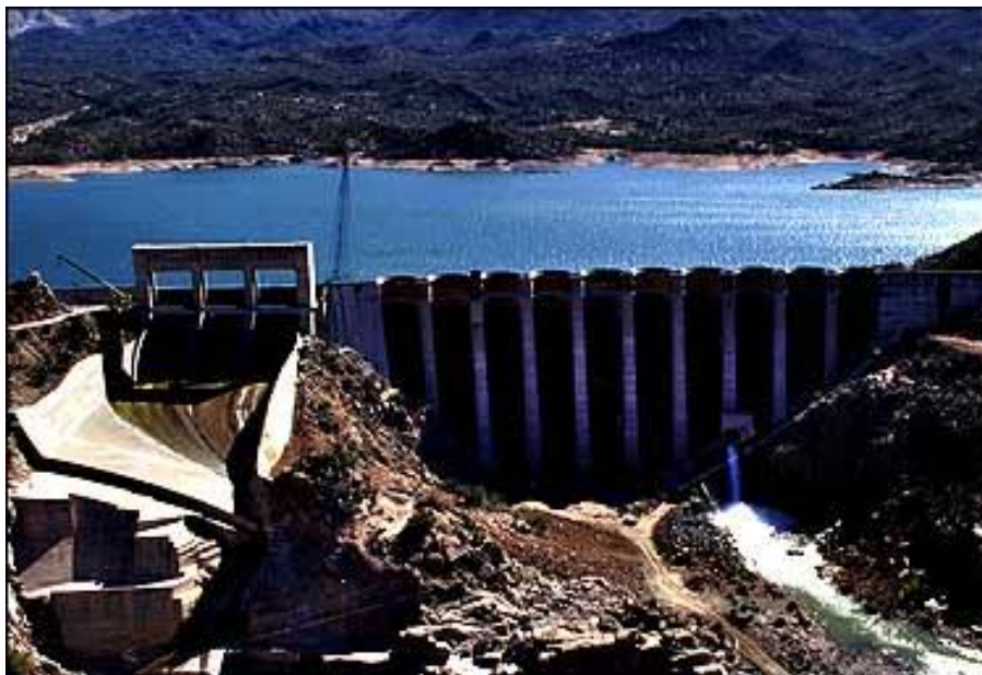
Figure I-6-Vue globale d'un Barrage à contre forts.
