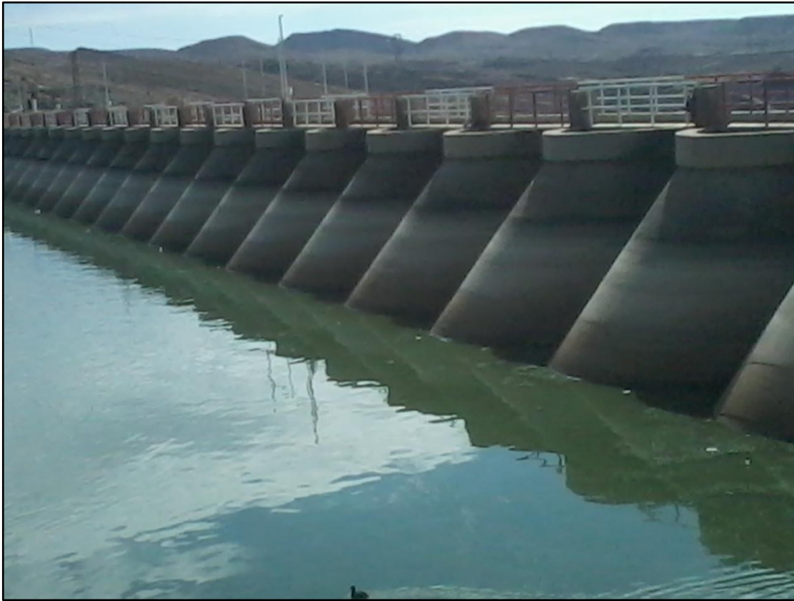
Figure III-6- Photo des voûtes en face amont du barrage K'sob.
