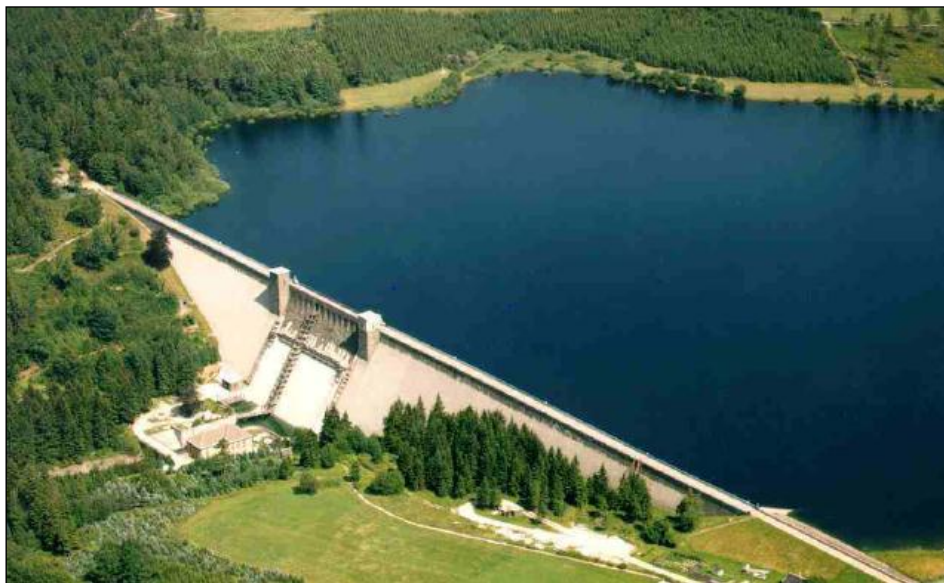
Figure I-3- Vue générale d'un Barrage poids.
