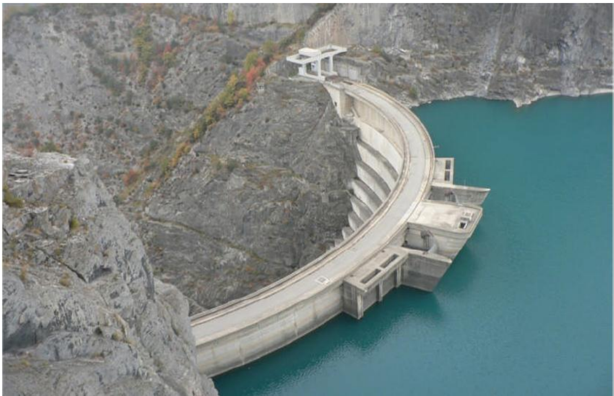
Figure I-4- Photo d'un barrage voûte.
