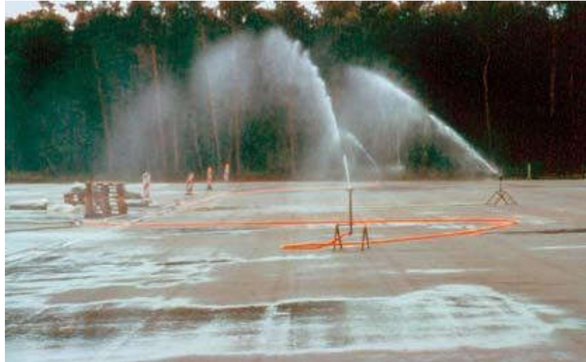
Figure.I.2.Cure du béton par arrosages ciblés [10].
