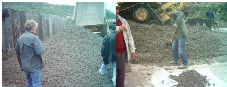
Figure.I.4.Etat du BCR frais lors de son déversement (Barrage Errmil Tunisie) [12].
