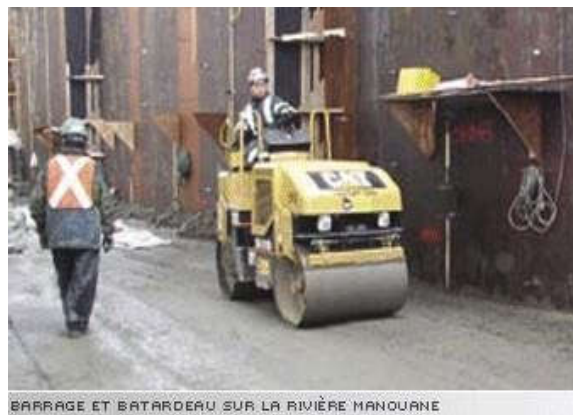
Figure.I.7.Barrage et Batardeau en BCR sur la rivière Manouane au Canada [13].
