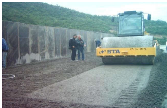
Figure.I.5.Compactage du BCR (Barrage en BCR Errmil - Tunisie)[12].
