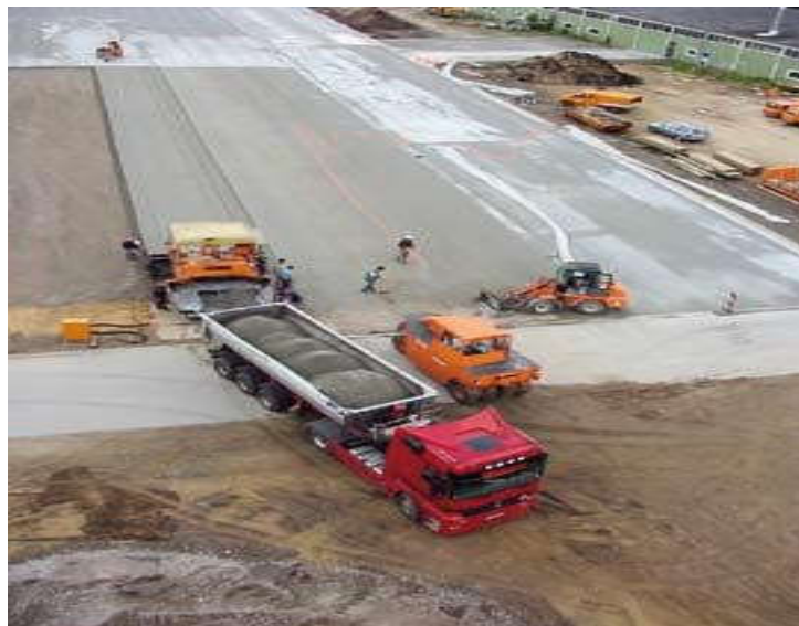
Figure. I.1. Mise en place de BCR par bandes [9].
