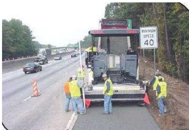
Figure.I.8.Mise en place du BCR en pavage, Atlant a USA [14].
