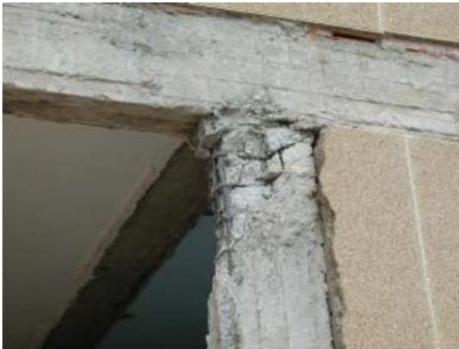
Figure I.22: Rotule dans le poteau [32].
