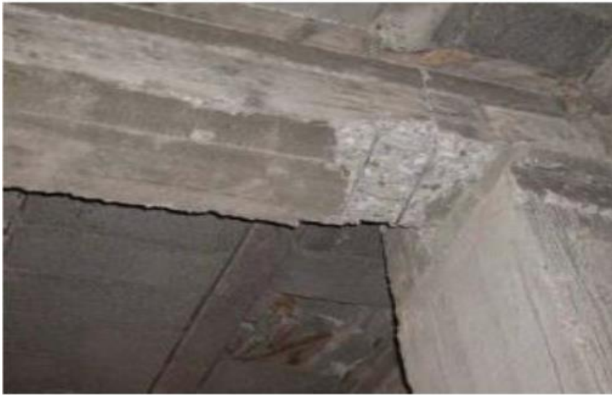
Figure I.23: Rotule dans la poutre [32].
