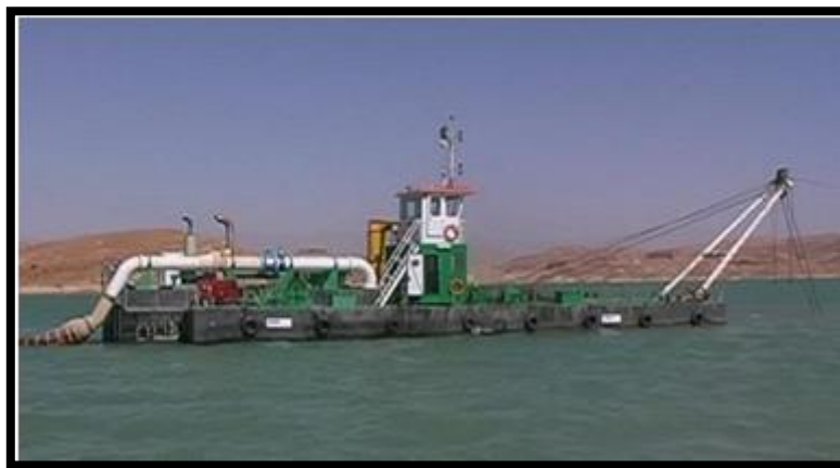
Figure II.11. La drague au centre du barrage de Foug El Gherza
