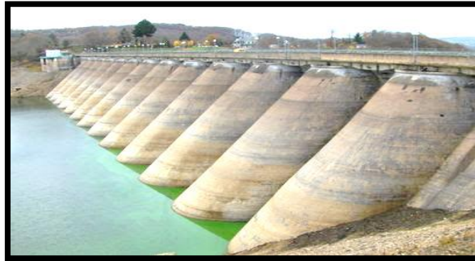
Figure I.8. Barrage à contrefort et à voûte multiple
