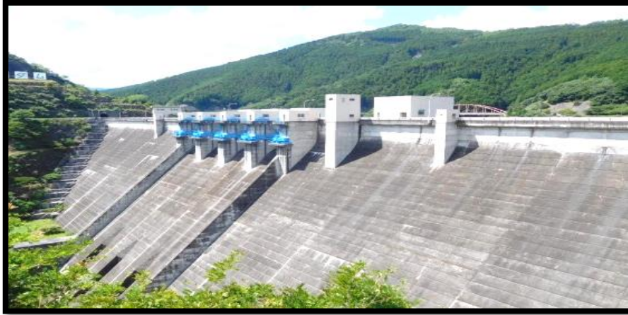
Figure I.6. Barrage poids
