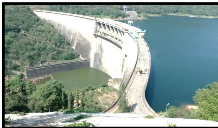
Figure I.7. Barrage voûte
