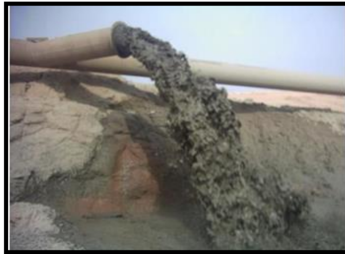
Figure II.12. Rejet de la vase lors de l'opération de dragage
