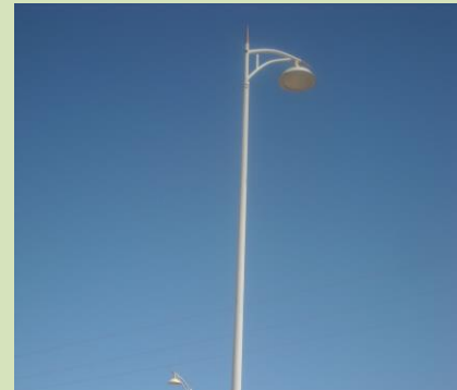
الصورة(66):أعمدة الإنارة قبل التدخل إعداد الطالبة 2014
