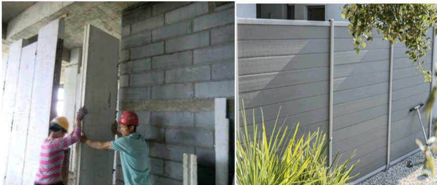
Figure.I: Quelque application du polymère pour l'isolation.
